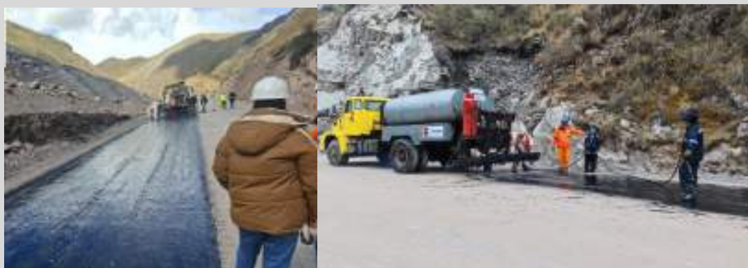
INICIO DE TRABAJO DE IMPRIMACION EN EL TRAMO II
