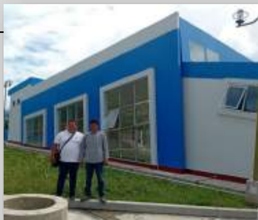
Inspección y monitoreo de los trabajos realizados en I.E de Pueblo Libre, durante el 20 de junio del 2024
