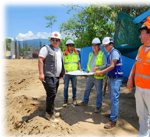
Inspección Y Monitoreo de los trabajos realizados durante el 24 de octubre del 2023
