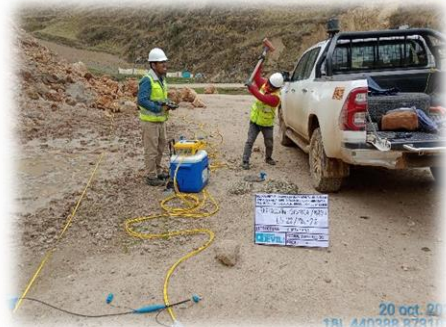
Refracción Sísmica y MASW LS-15/MW-15 ubicado en el tramo que recorre los distritos de Ricran, Tapo y Palca
