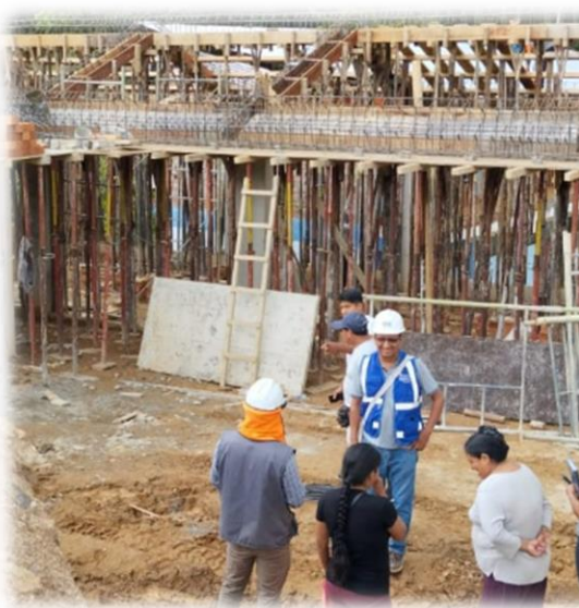
Inspección Y Monitoreo de los trabajos realizados durante el 20 de diciembre del 2023
