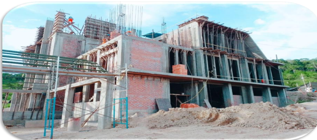
IMAGEN N°01: Construcción de nueva infraestructura de la UGEL RIO TAMBO, en el centro poblado de Nuevo Puerto Prado, Distrito de Rio Tambo, Provincia de Satipo, Departamento de Junín.
