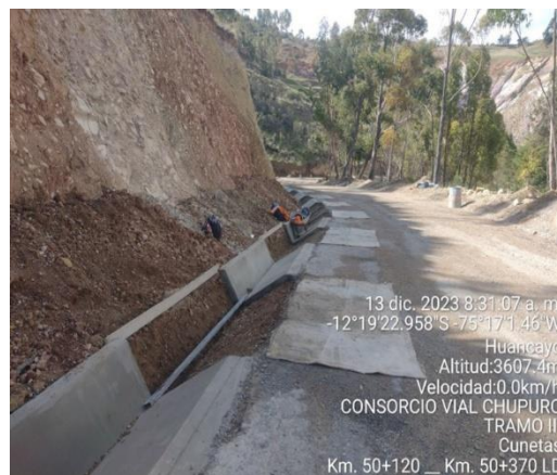
CONSTRUCCION DE CUNETAS REVESTIDAS DE CONCRETO TIPO I
