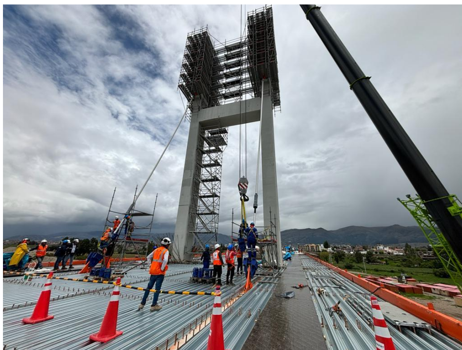
Montaje de los cables del atirantado, con utilización de grúas.
