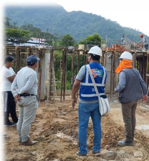
Inspección Y Monitoreo de los trabajos realizados durante el 20 de diciembre del 2023
