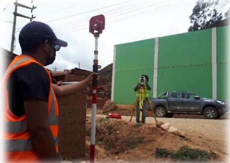
Levantamiento topográfico con estación total en el tramo Tapo - Tarma.
