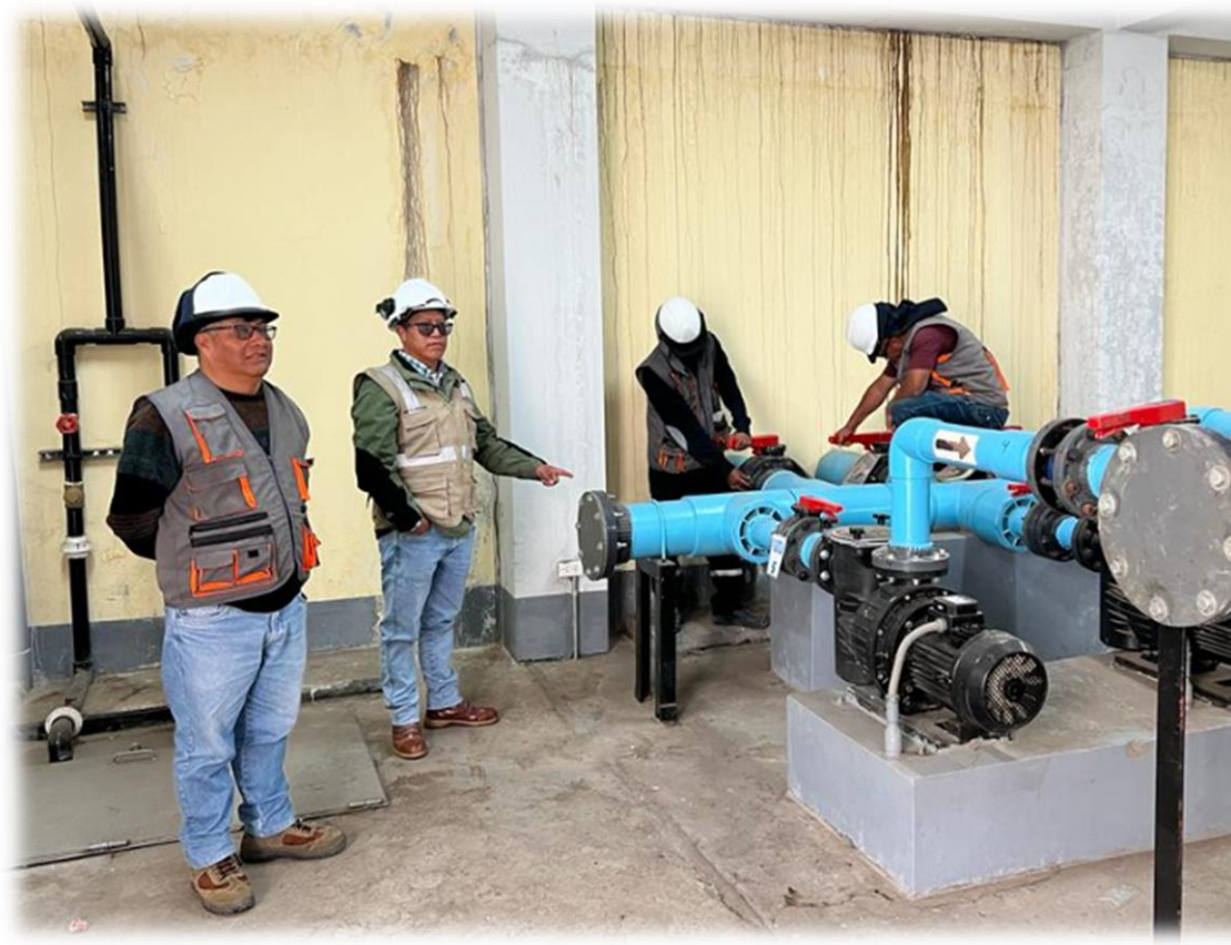
IMAGEN N°01: Trabajos de mantenimiento y puesta en funcionamiento de válvulas de la piscina de la I.E Santa Isabel.
