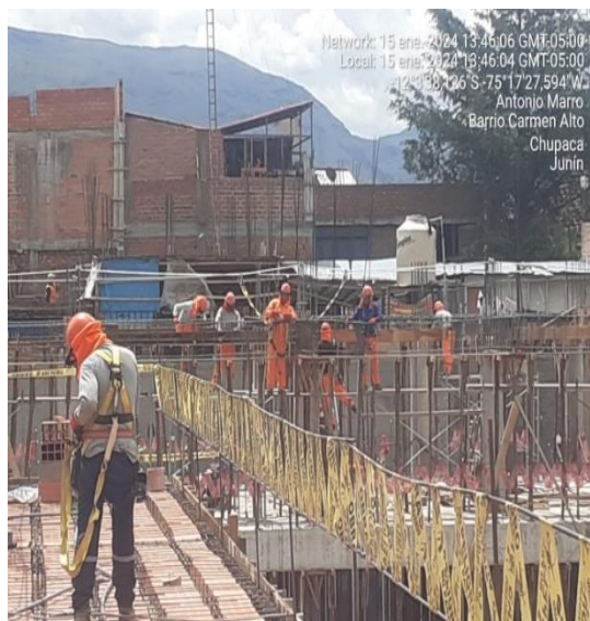
FOTOGRAFÍA N° 01: Se aprecia la personal laborando en segundo nivel de la infraestructura habilitando acero, Chupaca
