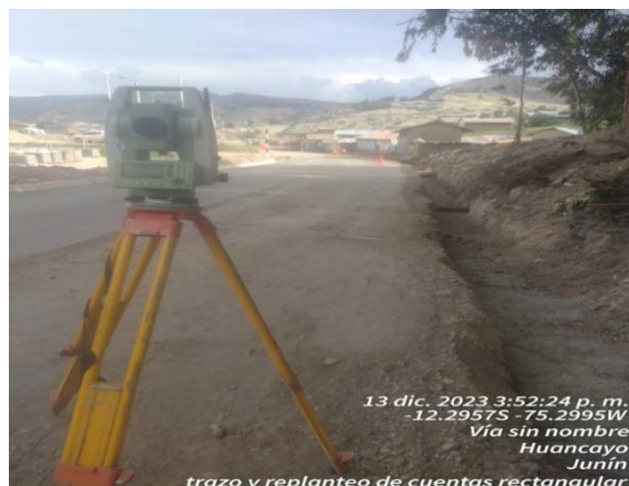
REPLANTEO TOPOGRAFICO DE CUNETAS
