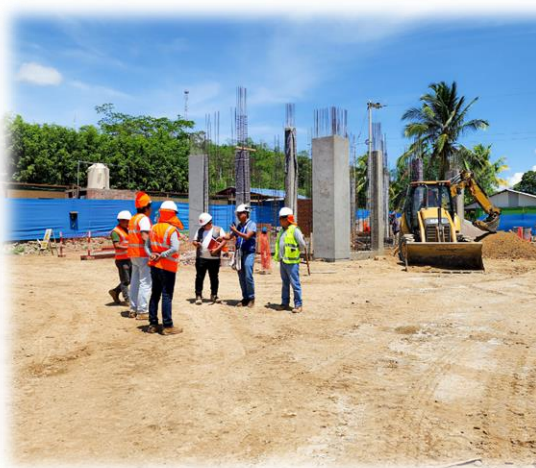
Inspección Y Monitoreo de los trabajos realizados durante el 24 de octubre del 2023
