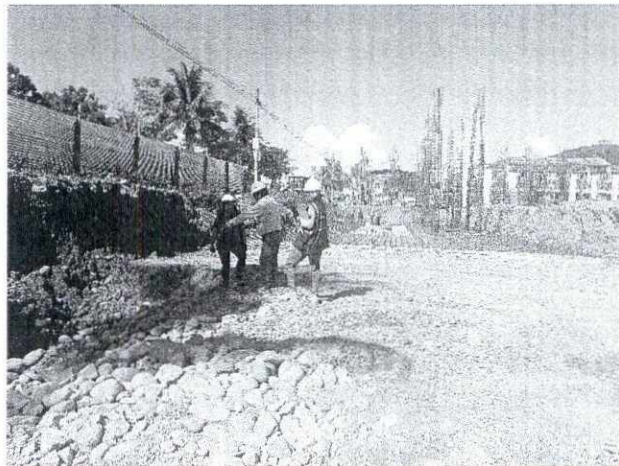
FOTO N°01 piedra medianas rellenado en la excavación realizado, no se realizó dren francés porque dejó de brotar el agua
