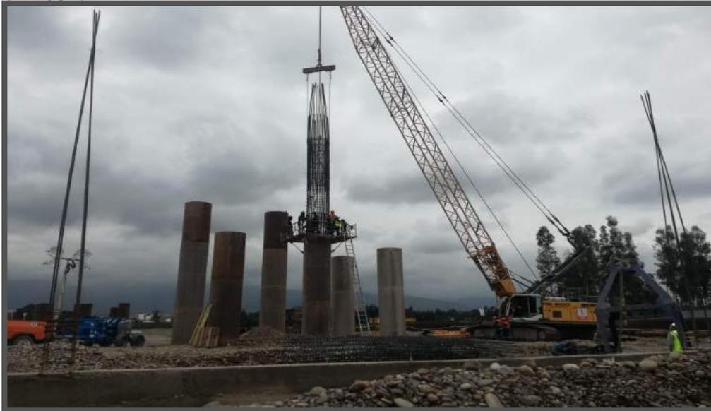
GRI: Proceso de vaciado de pilotes del Puente Comenros
