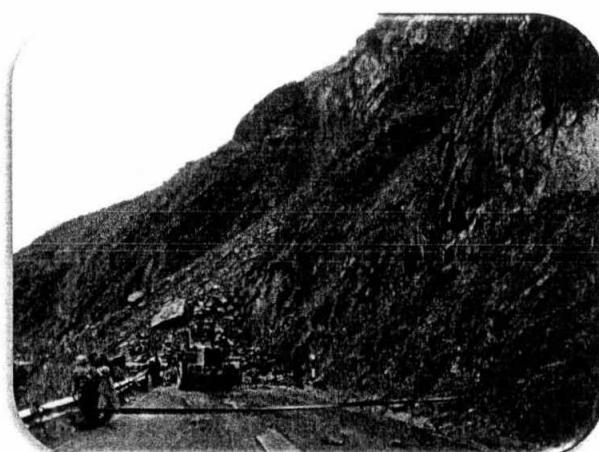
DERRUMBE CARPAPATA CARRETERA TARMA – CHANCHAMAYO
