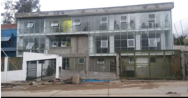
DESCRIPCION: VISTA FRONTAL DEL PUESTO DE SALUD
