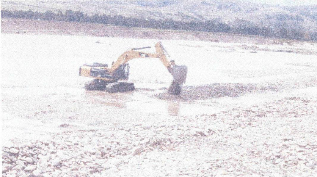
Se realiza la descolmtación del Rio Mantaro Sector La Isla (Hualhuas) en un ancho de 77.00 m, una longitud de 1,500.00 m y con una profundidad de 1.00 m de material colmatado.
