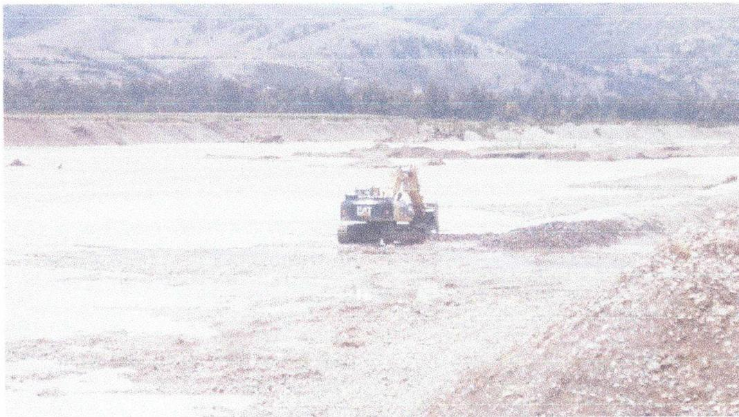
Se continua con la descolmtación del Rio Mantaro Sector La Isla (Hualhuas) en un ancho de 77.00 m, una longitud de 1,500.00 m y con una profundidad de 1.00 m de material colmatado
