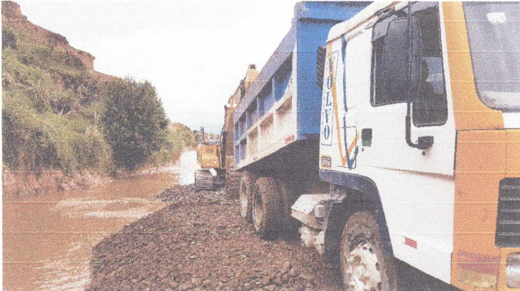
Se transporta el material con la ayuda de camión volquete de 15m<sup>3</sup> para la conformación de dique a lo largo del tramo.
