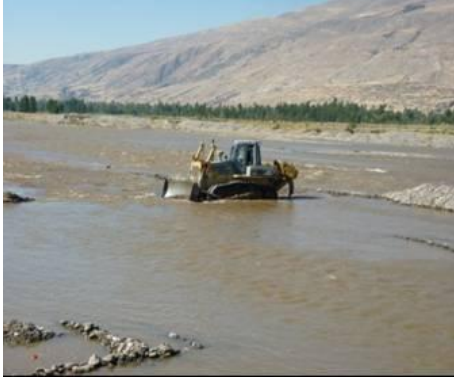
Maquinaria pesada realizando trabajos de descolmatación. Beneficiarios coordinando.
