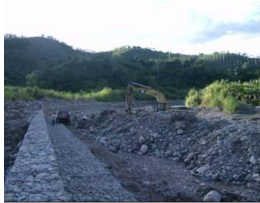
Muros gavionados y descolmatación de cauce.
