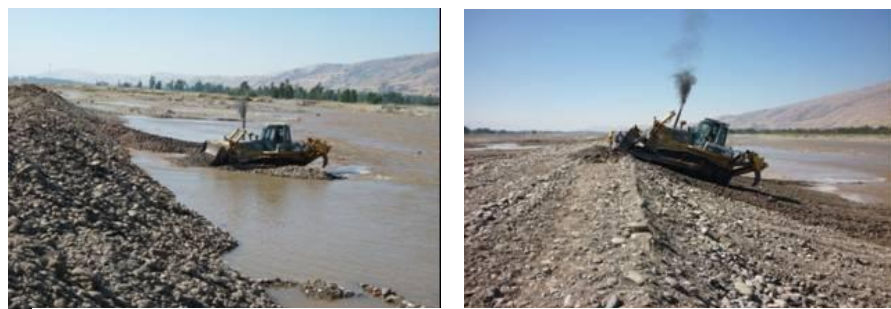
Acumulación de material de río en la conformación de dique y perfilado del talud de la cara húmeda.
