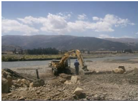
Maquinaria pesada en pleno trabajo de conformación de dique y el perfilado del talud de la cara húmeda.
