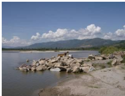
Acumulación de roca y construcción de espigones.
