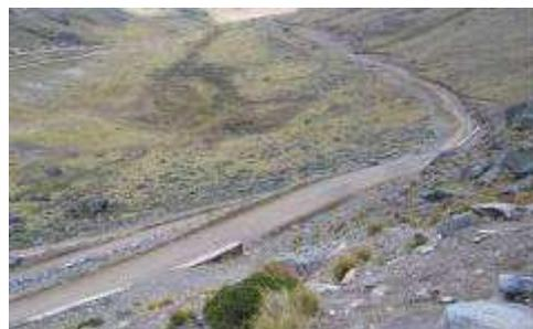
Este proyecto consistió en el mantenimiento de carretera afirmada, rehabilitación de pontones, mantenimiento y construcción de mampostería, rehabilitación de alcantarillas, colocación de señales informativas. Este trabajo se hizo en un tramo de 47.7 kilómetros de esta vía, habiéndose alcanzado el 100% de la misma. Fue necesario realizar una inversión de S/. 1'359,430 Nuevos Soles.
