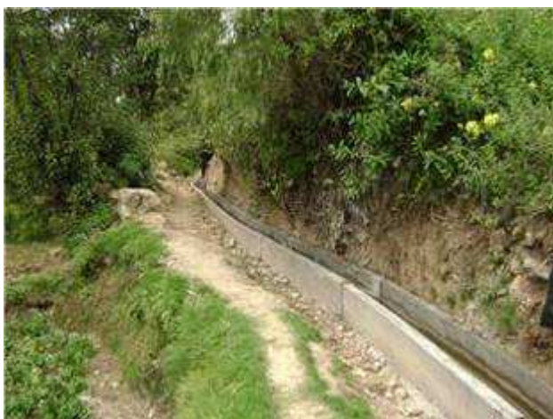
Canal de irrigación en culminado y en pleno funcionamiento.
