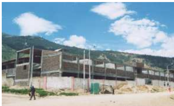
Construcción de ambientes de Institución Educativa.
