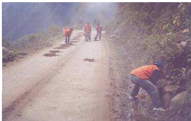
Personal obrero de microempresas en plena labor de mantenimiento de vía.
