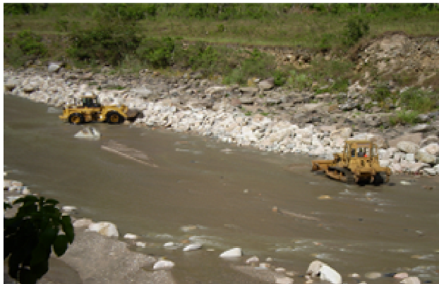
Limpieza del cauce del río Huacará
