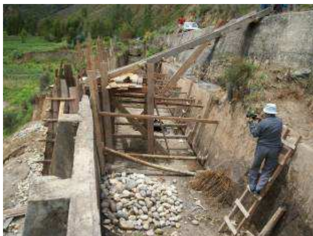
Trabajos de mejora de infraestructura de riego del canal CIMIRM
