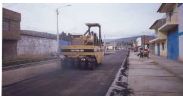
Asfaltado de vías en convenio con Gobiernos Locales.
