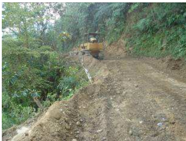
Maquinaria pesada en pleno trabajo de rehabilitación de vía.
