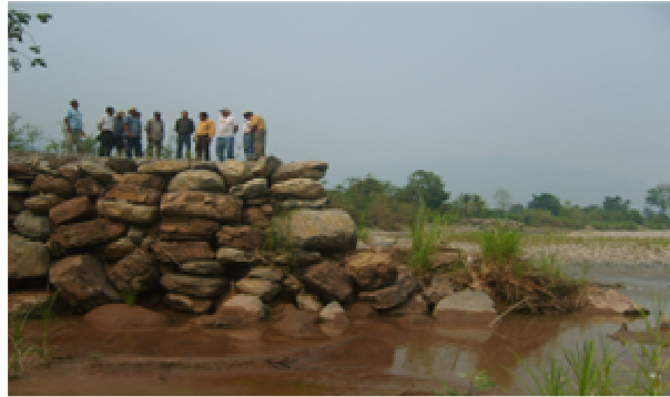
Entrega de obra de Defensa Ribereña
