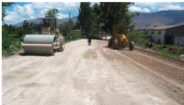
Maquinaria pesada en pleno trabajo de mejoramiento de vía.
