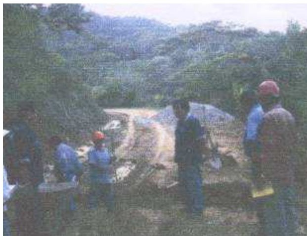
Obreros en pleno trabajo de rehabilitación de camino vecinal.
