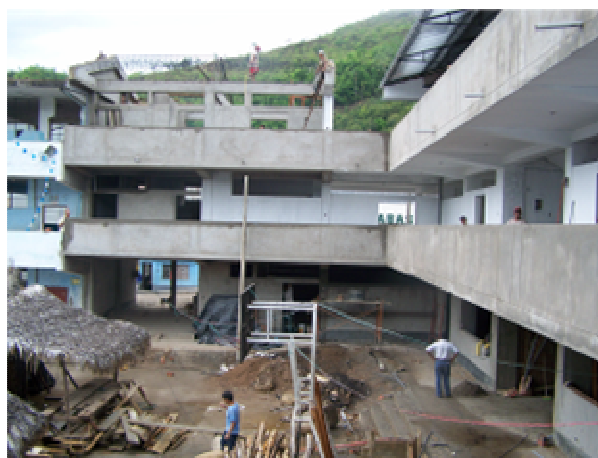
Pabellón de Institución Educativa, en plenos trabajos de tartajeo.
