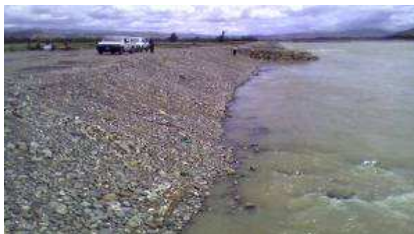
Corrección de cause de Río Mantaro en el Sector Muqui.
