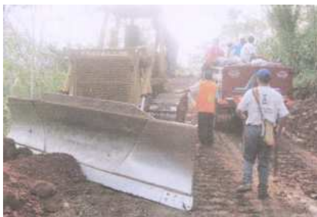
Maquinaria pesada en pleno trabajo de mejoramiento de trocha carrozable.
